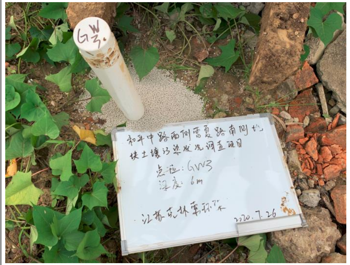
图 6-3 监测井建井照片
