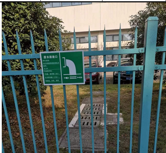
图 3-1 生活污水排口照片
