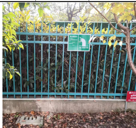
图 3-2 雨水排口照片
