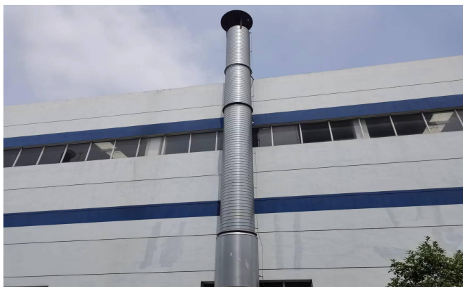
辊涂工段有机废气收集措施及二级活性炭处理设施
