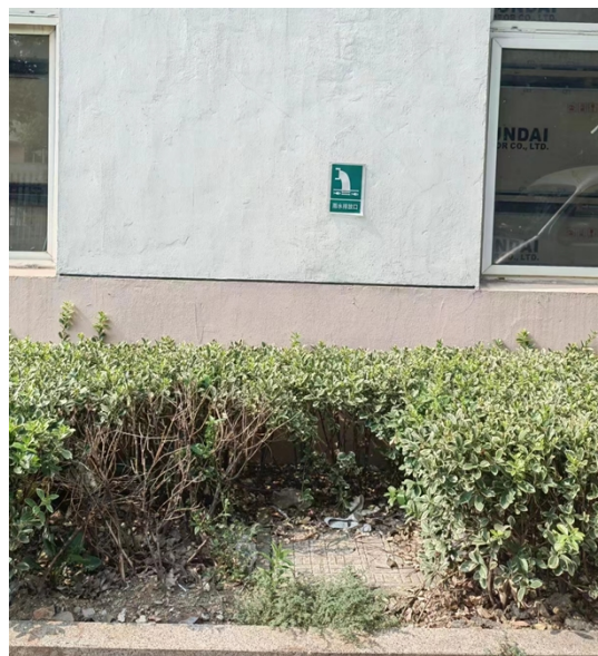
图 3-4 雨水水排口及标识照片
