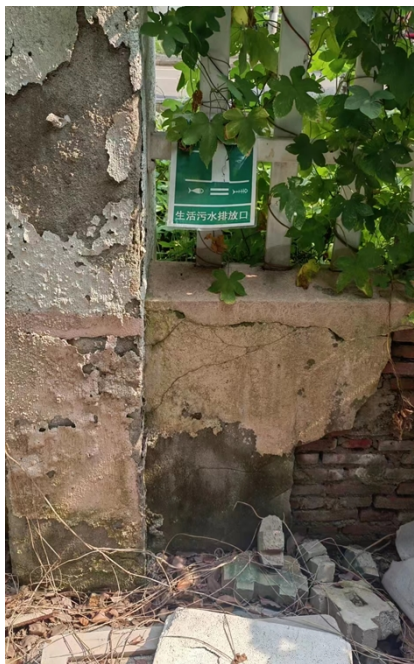
图 3-3 生活污水水排口及标识照片
